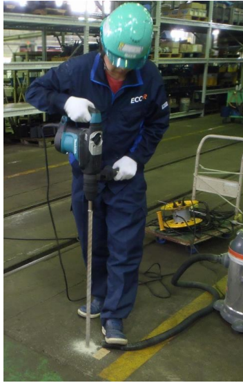
ドリルで削孔 (地表面がアスファルト等で舗装されている場合)
