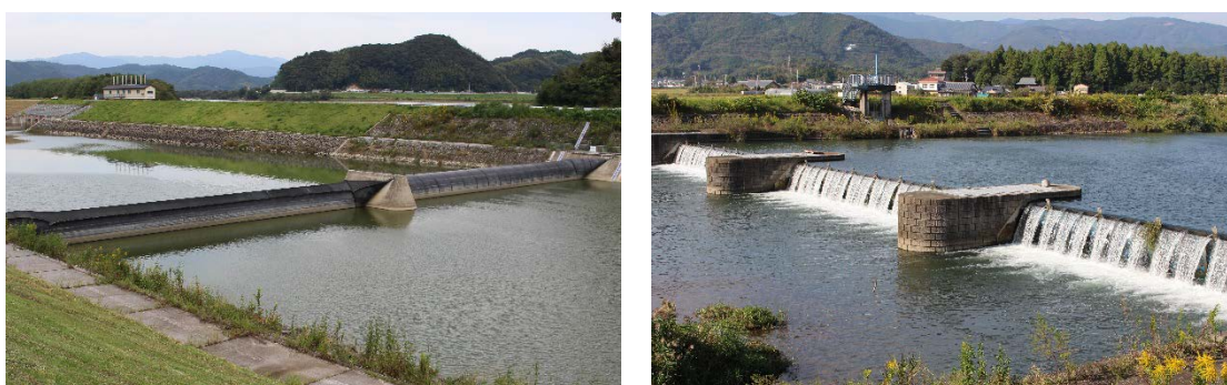
図 起伏(ラバー)堰(左)と引上堰(右)の例
